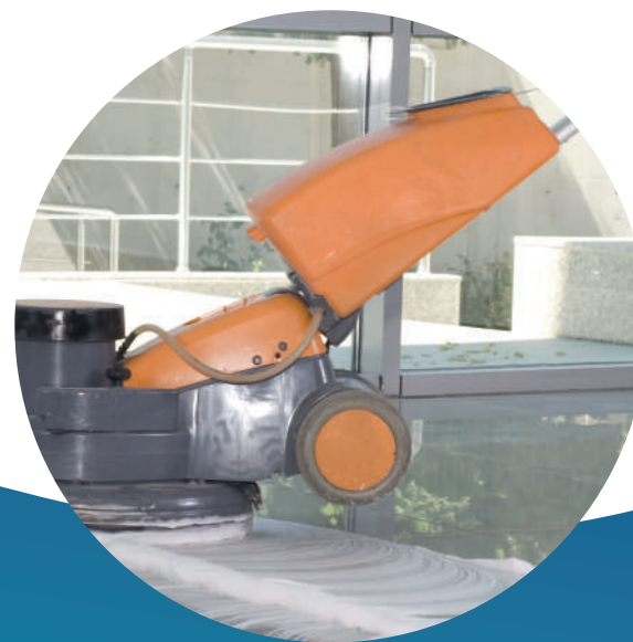
Revitalização e Tratamento de Piso
